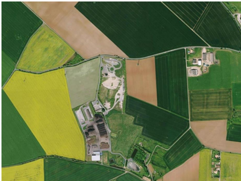
Figure Diagnostic 411 : La déchèterie et le centre de transfert du Vallon d'Arty à Niort (Source : Géoportail)
