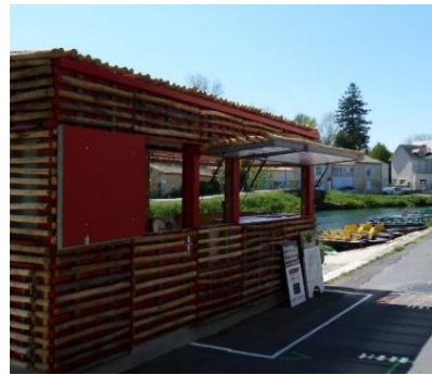
Figure Diagnostic 438 : Billetterie pour les balades sur la Sèvre à Coulon
