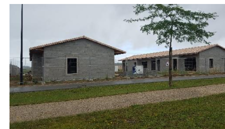
Figure Diagnostic 266 : Nouvelles constructions à Chauray
