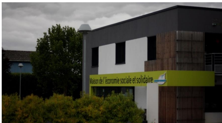
Figure Diagnostic 105 : Maison de l'Économie sociale et solidaire à Niort
