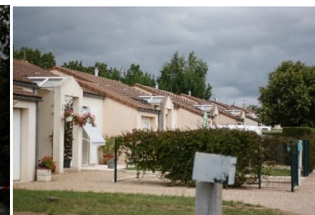
Figure Diagnostic 281 : LLS en individuels, Frontenay-Rohan
