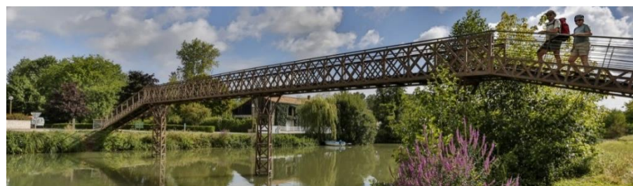
Figure Diagnostic 71: Passerelle métallique au Vanneau Irleau (©Niort Agglo)
