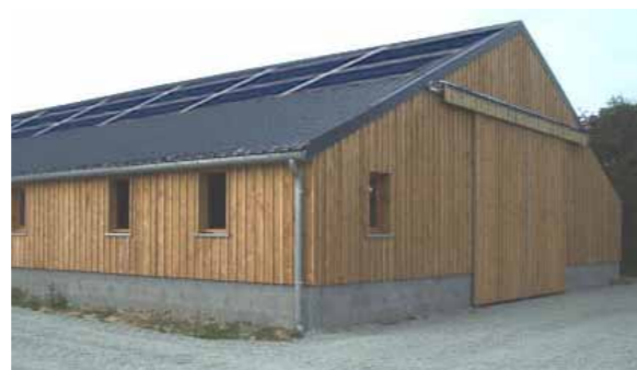
Image 2 : implantation de capteurs au faîtage de la couverture
