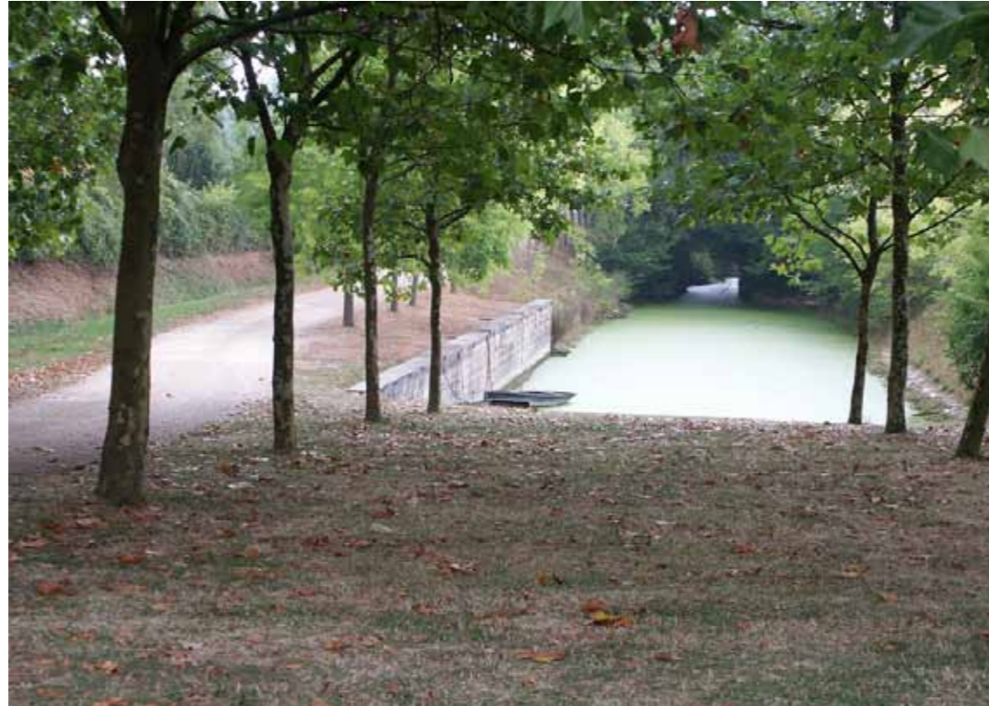
Exemples intéressants de traitement de cales sur une commune voisine
