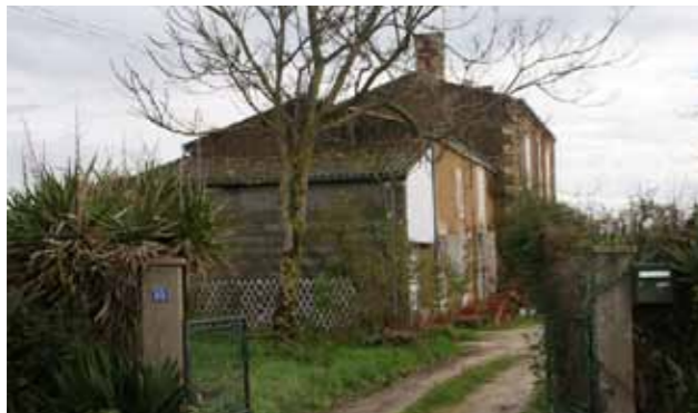
Dépendance à l'Ouest de la façade principale
