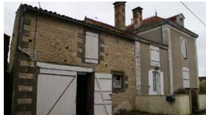
Dépendance au Nord-l'Ouest de l'habitation
