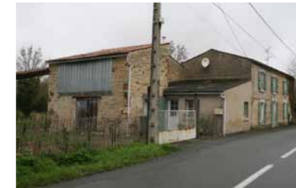
Dépendances au Nord et à l'Ouest de l'habitation
