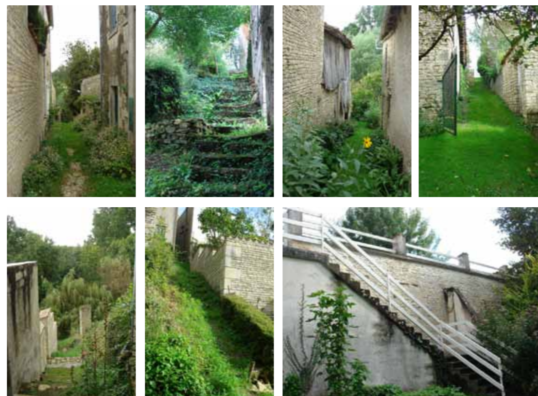
Traitement de la déclivité à éviter
