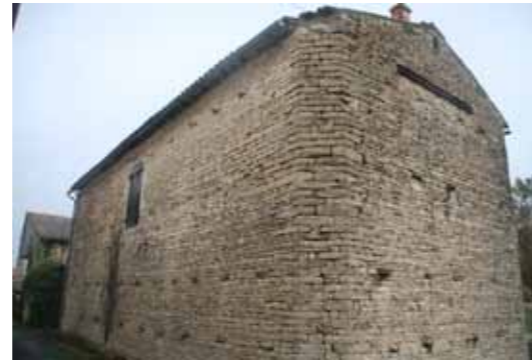
Maisons avec façades Nord et Ouest aveugles
