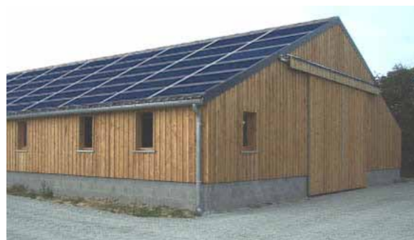
Image 1 : implantation de capteurs sur 100% de la couverture
