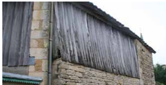
Bardage bois pour fermeture des bâtiments agricoles
