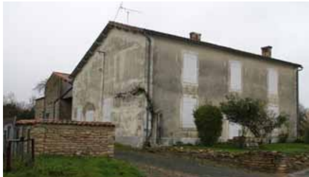
Protection dans le prolongement de la toiture au Nord
