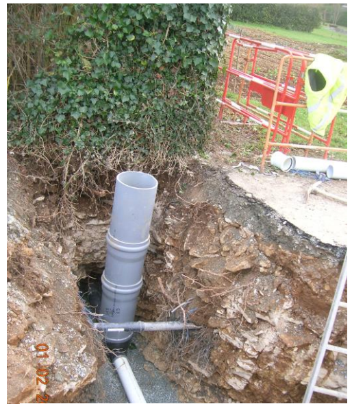
Figure 3 : réalisation d'un branchement
