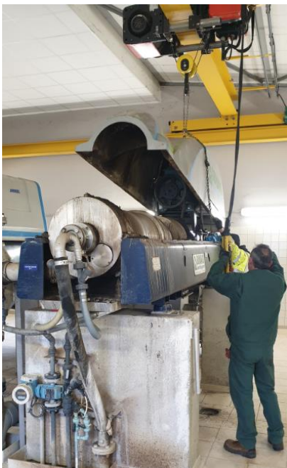
Remplacement des courroies et contrôle centrifugeuse, STEP Goilard-
