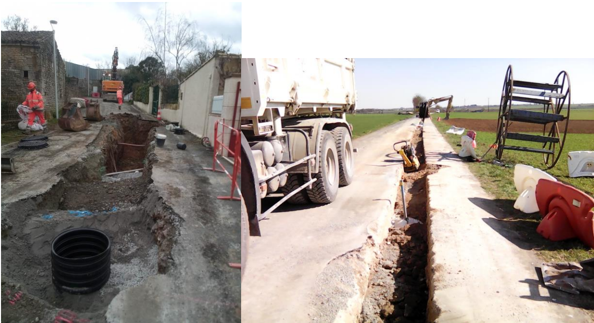
Renouvellement réseau Aiffres
