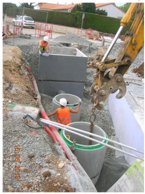
Figure 7: pose d'un réseau eaux pluviales
