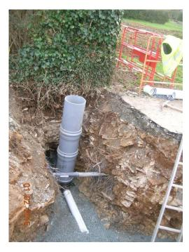
Figure 4 : réalisation d'un branchement
