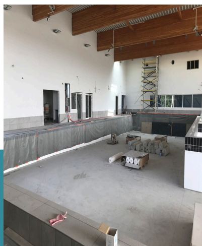
Chantier Centre Aquatique de Saint Maixent l'Ecole
