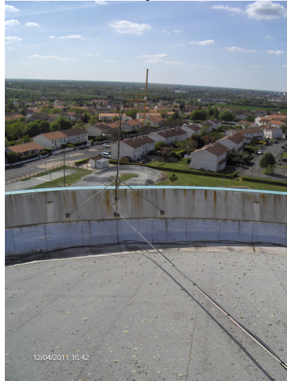
Chemin de câble D4B coupole
